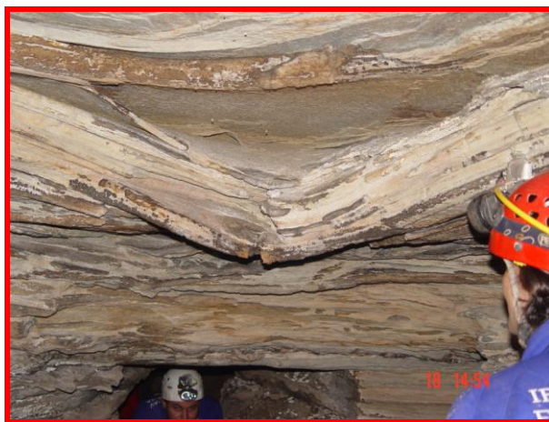
Fig. 7. Instabilidade geológica verificada em um dos condutos estreitos e de teto baixo, que caracterizam a Gruta das Cortinas de Baixo. Acervo Cecav/Ibama. Foto: Joyce Fiori.
