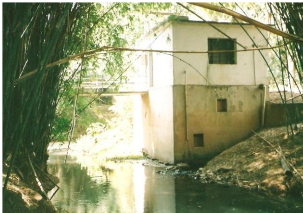
Figura 12 – Elevatória de água bruta para abastecimento de água potável da população de Pains.
