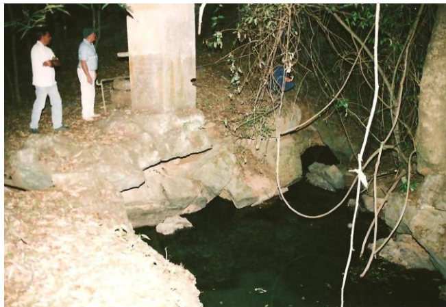
Figura 6 – Surgência considerada como sendo o ponto de reaparecimento da água que passa pela galeria de superfície potenciométrica da Gruta do Éden, com destaque para o pila de elevação da bomba para recalque de água.
