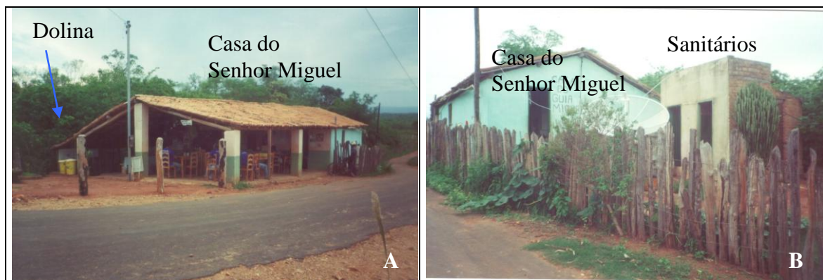
Figura 10 – A) Casa do Senhor Miguel. Esta casa, além de estar no limite de 250 m, está parcialmente dentro da dolina de Poço Encantado. B) A casa possui dois sanitários que despejam seus dejetos numa fossa que se localiza também dentro da dolina.
