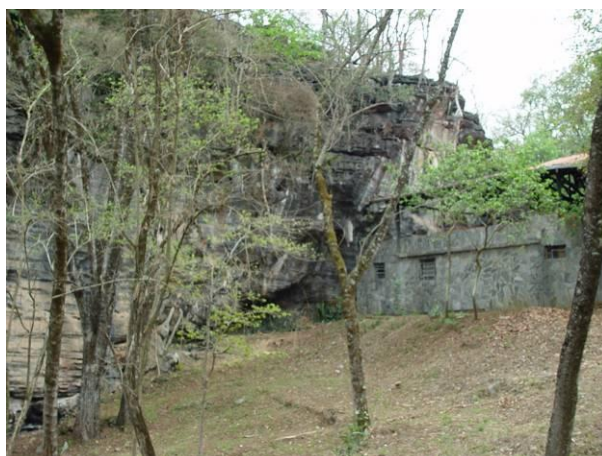
Foto 13: vista da parte lateral do centro de visitantes, construído junto ao paredão e próximo da gruta da Macumba (Guilherme Vendramini – acervo CECAV).
