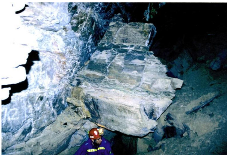
Foto 7: passagem para o lago subterrâneo. A estrutura que se projeta da parede está ligada a esta por um plano de fratura. Não há qualquer outro ponto de apoio para esta saliência da rocha.
