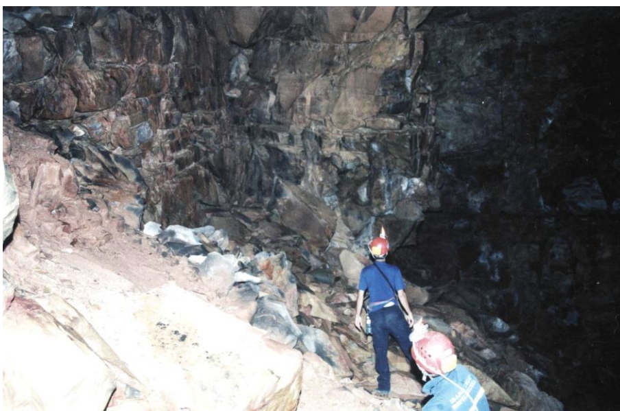
Foto 6: zona de maior risco ao final da Gruta Norte. Intenso fraturamento e deslocamento visível de blocos na parede. Carreamento de fragmentos motivados por água de infiltração. Autor:Guilherme Vendramini Acervo CECAV.
