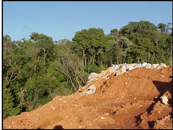
Figura 51 – Vista lateral do mesmo aterro evidenciando a morte das árvores.
