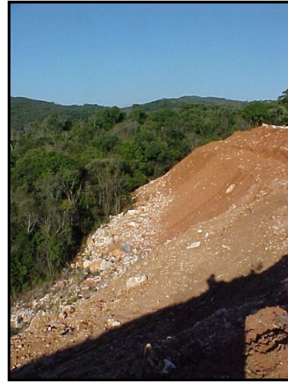
Figura 55 – Outra vista do aterro principal soterrando a floresta, da base ao topo há quase 20m de altura.
