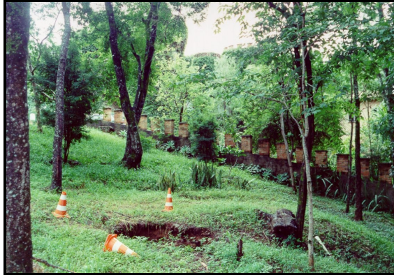
Figura 09 – Vista da erosão provocada pela fossa instalada no interior da dolina entre o castelo e o receptivo.
