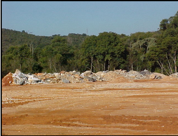
Figura 50 – Vista superior do aterro das pedreiras, localizado à montante na bacia do Rio da Lança, soterrando a floresta e algumas nascentes.
