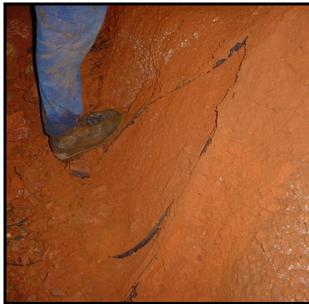
Figura 46 – Tubulação de fios elétricos desprotegidos na passagem de pedestres.
