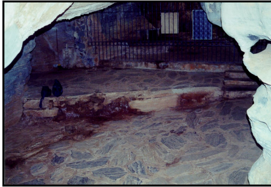
Figura 11 – Vista do portão no interior do salão da entrada e o piso reformado com cimento e pedras.
