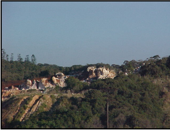
Figura 54 – Vista de outro paredão de desmonte próximo ao aterro. Observa-se outro aterro mais antigo no primeiro plano da foto (essa foto foi feita com o zoom máximo da câmera fotográfica).
