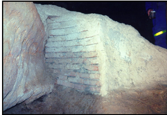
Figura 34 – Luminária muito grande feita de tijolo, parcialmente aparente, e concreto, destoando do ambiente.
