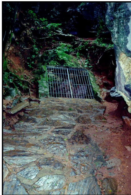
Figura 15 – Vista do portão que fecha totalmente a gruta sem permitir a saída fácil dos morcegos e aves, além da impermeabilização do piso com cimento e pedras.
