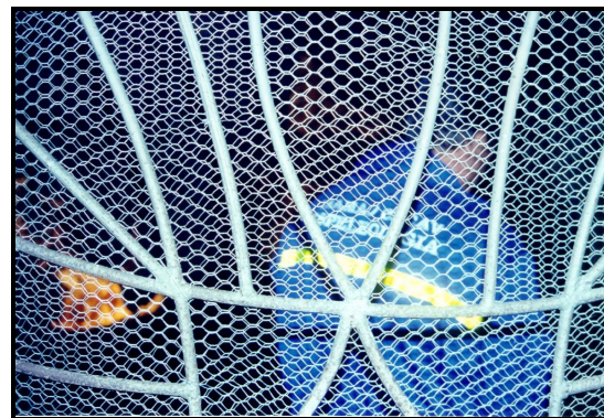
Figura 28 – Detalhe do portão da figura anterior, evidenciando que não há espaço para os morcegos adentrarem a caverna.
