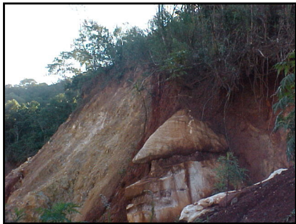
Figura 53 – Paredão mostrando o desmonte de calcário próximo ao aterro.
