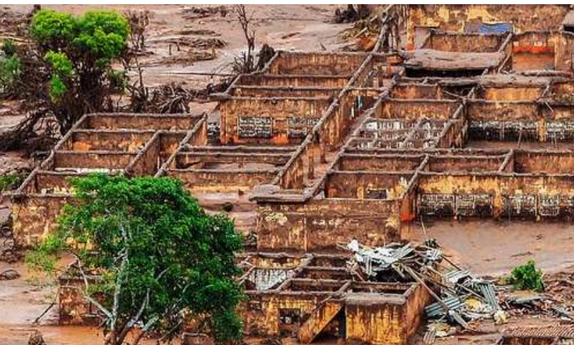
Figura 25: Quebra da barragem da mina Córrego do Feijão, Brumadinho (MG). Foto: Antônio Cruz/Agência Brasil
