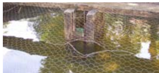
Figura 15. Tela de cobertura de tanque de piscicultura danificada por lontras.
