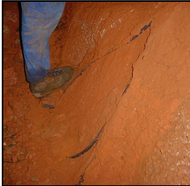
Figura 07 – Tubulação de fios elétricos desprotegidos na passagem de pedestres.
